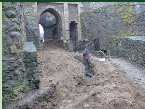
Výkop pro suchovod mezi III. a IV. bránou.
