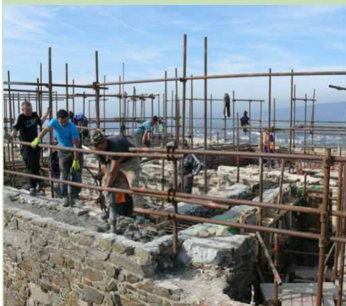
Betonáž věnců severního křídla hradního paláce.
