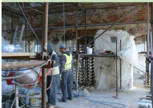
Aplikace odsolovací buničiny v místnostech paláce.
