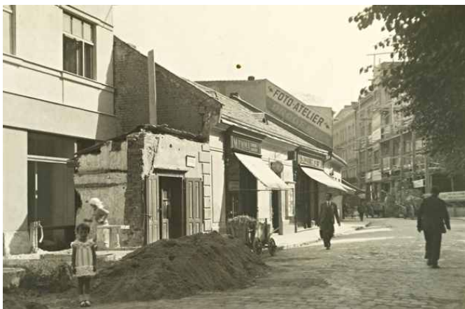
Stavební ruch v Kartochovilově ulici v roce 1928. Za pošvinnutí stojí dokončování komplexu pasáže (vpravo) a zachované zbytky původního domu čp.146 (vlevo v popředí) a za nimi novostavba, která jej nahradila. Dnes je zde kavárna Echocafé.
