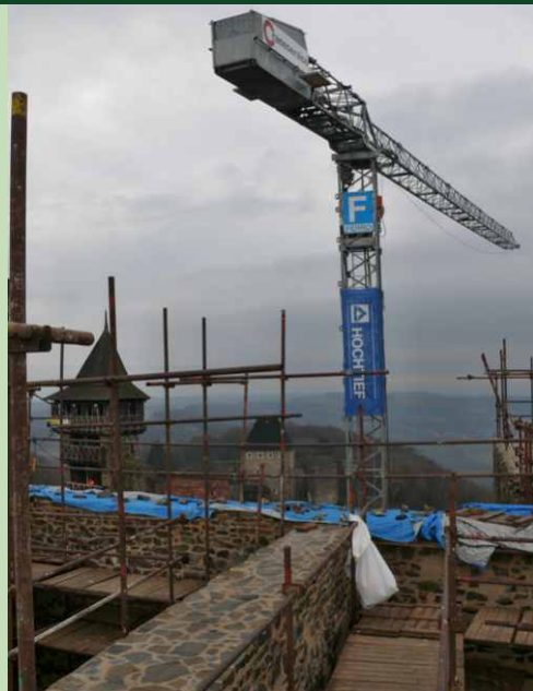
Nově obložené koruny zdiva s věžovým jeřábem v pozadí.
