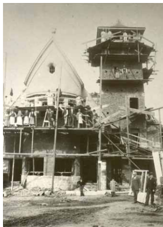
Dělníci při dostavbě evangelického kostela na Velkých Novosedcích v roce 1907.
