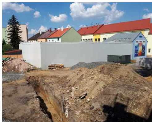
Přerov. Brabansko. Celkový pohled od jihu na výkop inženýrských sítí.
