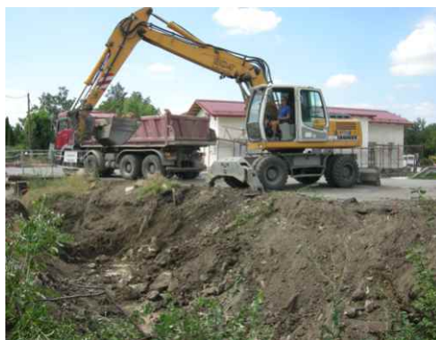
Výstavba nového nádraží a kolejíště Sedlec nás chvílemi nechávala na pochybách, zda se z Nesytu vrátíme zpět.
