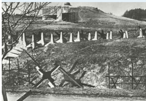
V druhé půli 30. let začala na obranu republiky vznikat „hráz“ železobetonového opevnění.
